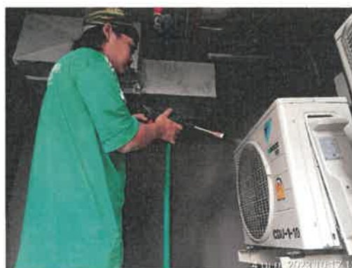
ทำความสะอาดเครื่องปรับอากาศ
